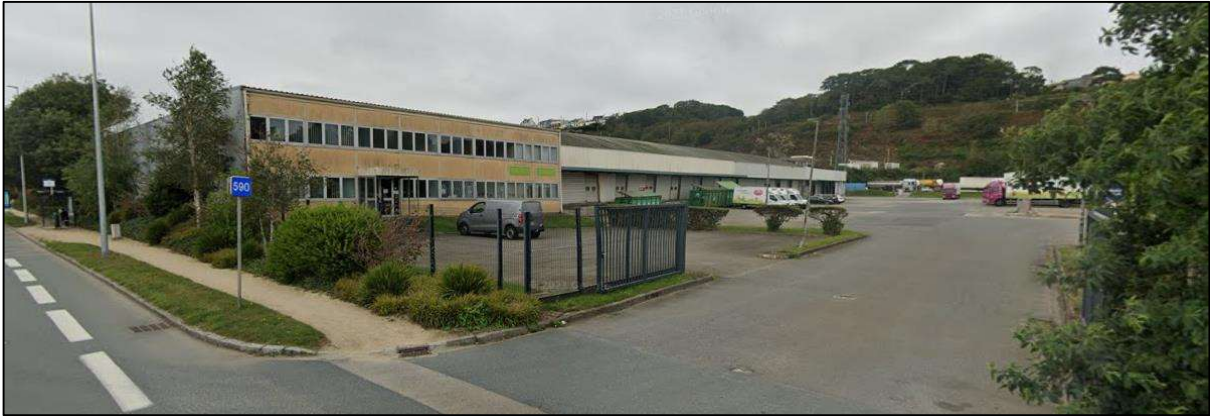
Photos bâtiment 8 - (source Google Street)
