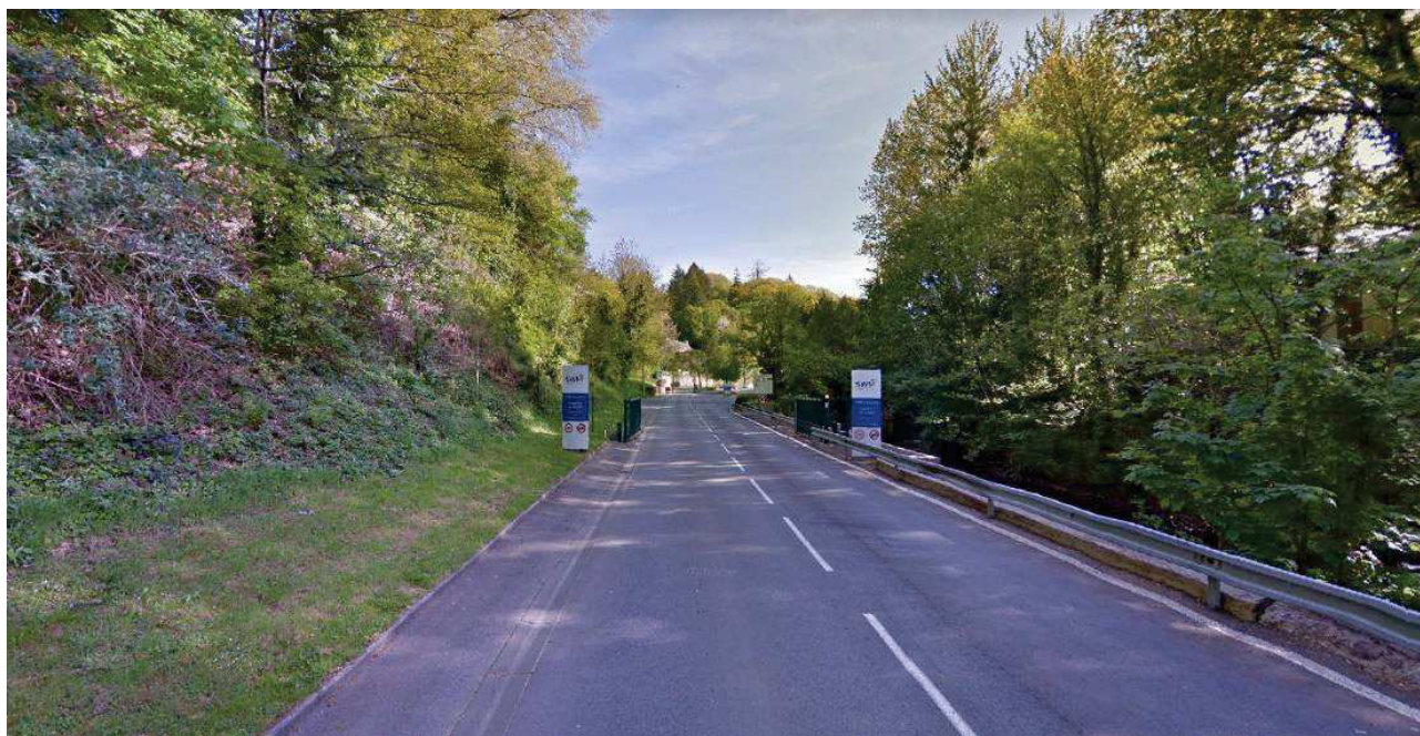
Figure 7 : Photographie du point d'entrée / sortie au site PDM Industries
