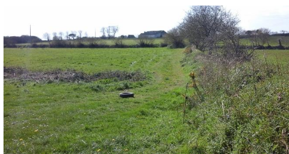
Ouvrage agricole de franchissement
