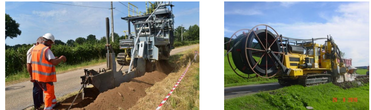
Figure 205 : Exemple de trancheuse en action (Source : Le Journal de Saône et Loire ; Tattu TP)
