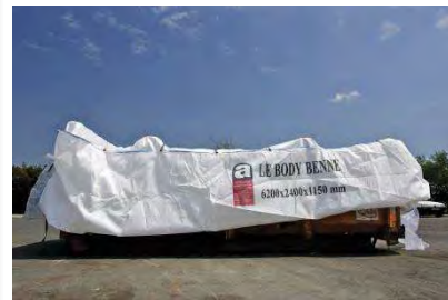
Body benne 15 m3, marquage amiante, double sac est mis à l'intérieur de la benne de 15 m3.
