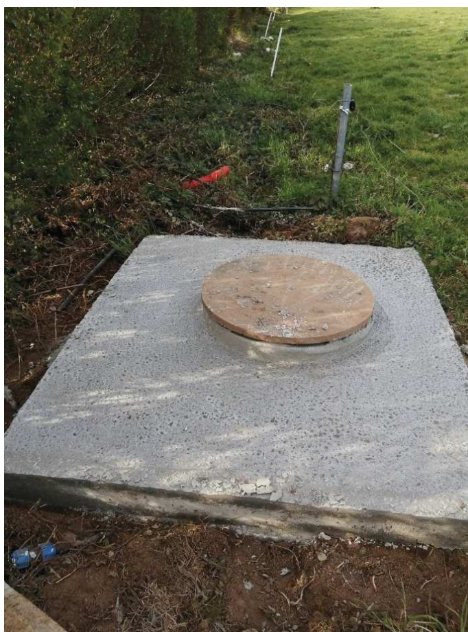
Photo de la tête du forage
