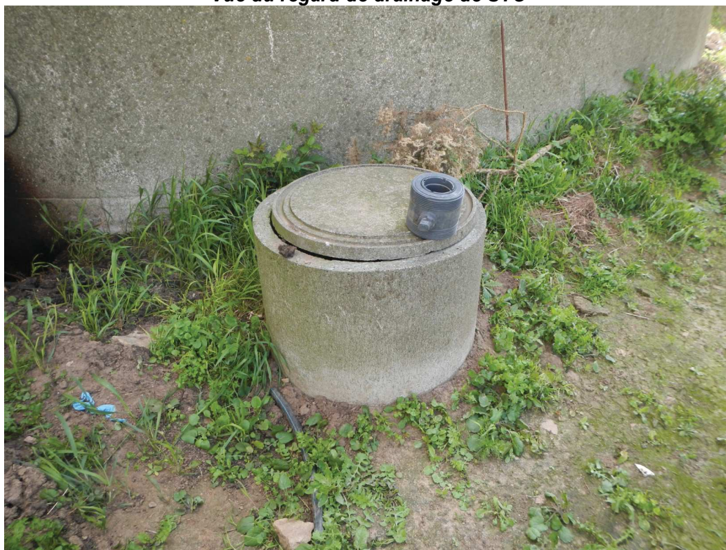
Vue du regard de drainage de STC
