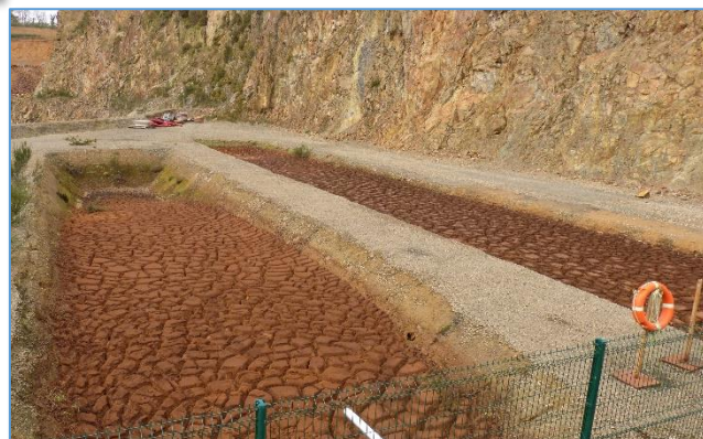
Fig. 13 : Vue sur les bassins à boues de l'unité de neutralisation de l'acidité des eaux d'exhaure
