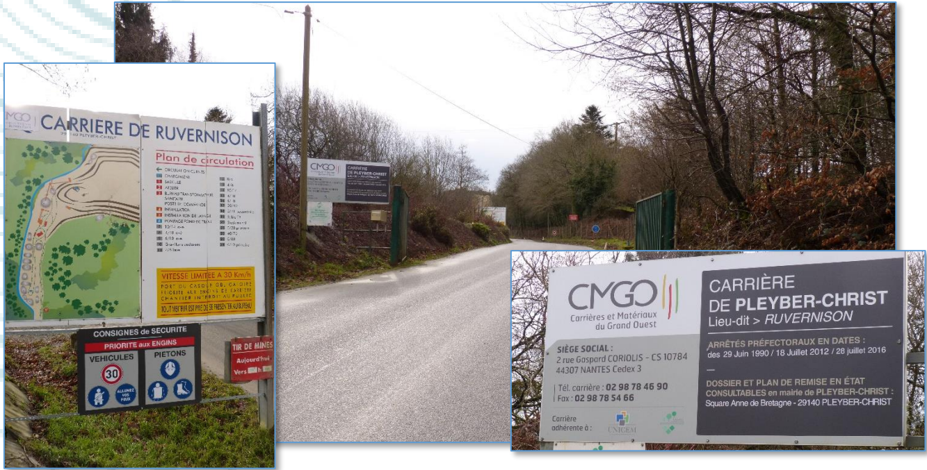
Fig. 14 : Vue n°1 : Accès au site et signalisation
