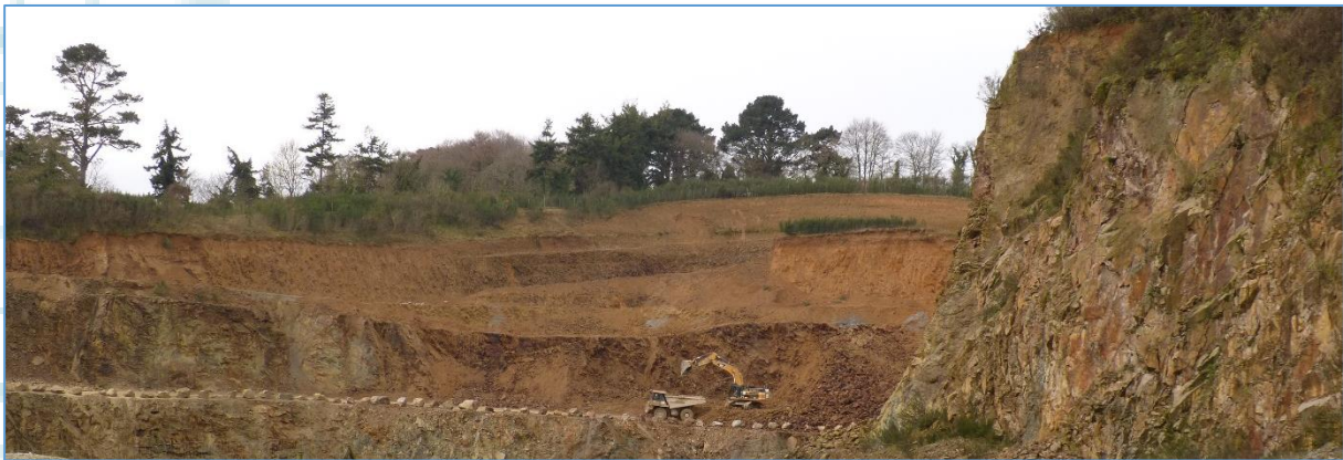
Fig. 21 : Vue n°8 : Reprise des matériaux bruts en pied de front à la pelle
