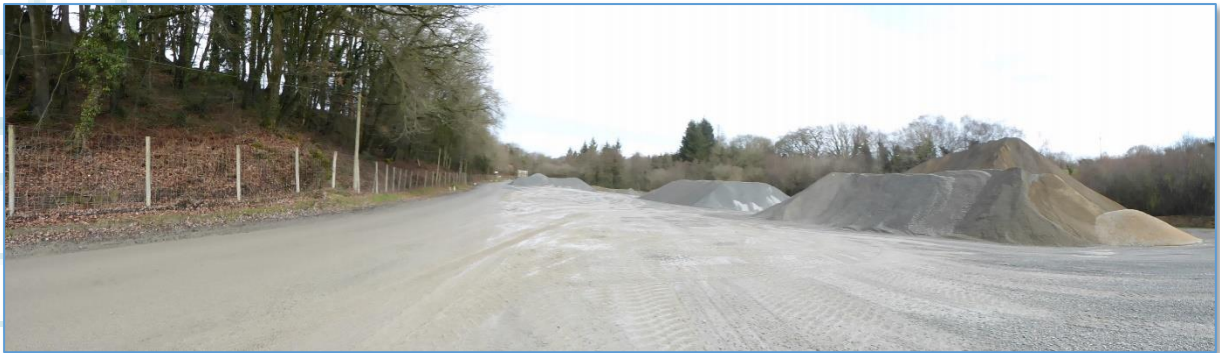
Fig. 15 : Vue n°2 : Plate-forme de stockage des matériaux à l'entrée de la carrière
