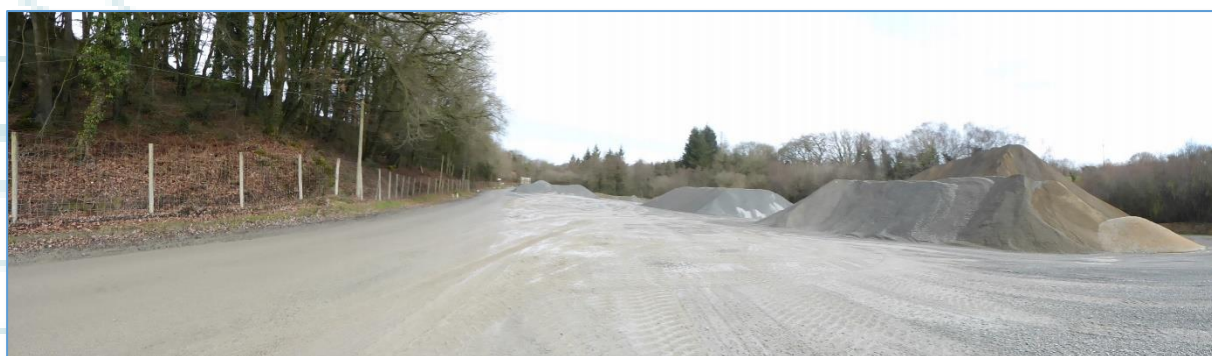
Fig. 11 : Vue n°2 : Plate-forme de stockage des matériaux à l'entrée de la carrière
