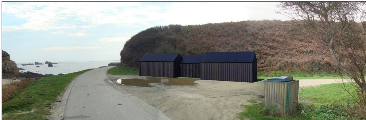
Figure 11 : Insertion paysagère du poste de livraison (A3P, 2019)
