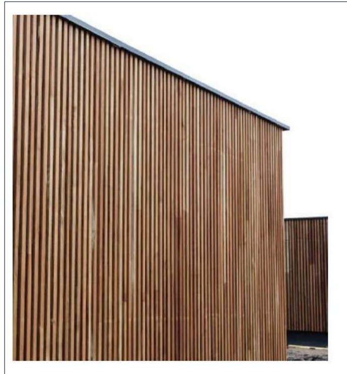
Figure 9 : Bardage bois type mis en œuvre pour le poste de livraison (A3P, 2019)
