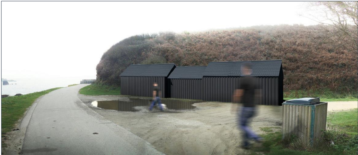
Figure 10 : Toiture en ardoises du poste de livraison (A3P, 2019)
