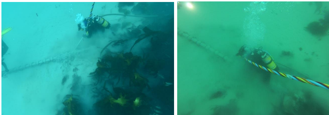
Figure 7 : Ensouillage du câble sur la partie sableuse (SABELLA SA)
