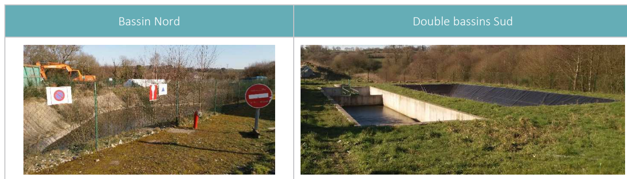
Figure 20 : Photographies des bassins de gestion des eaux pluviales (Nord et Sud)
