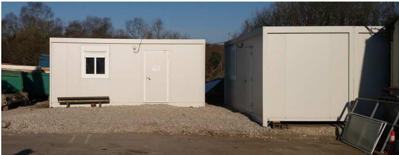
Figure 16 : Photographie des blocs modulaires vestiaires / sanitaires du personnel d'exploitation
