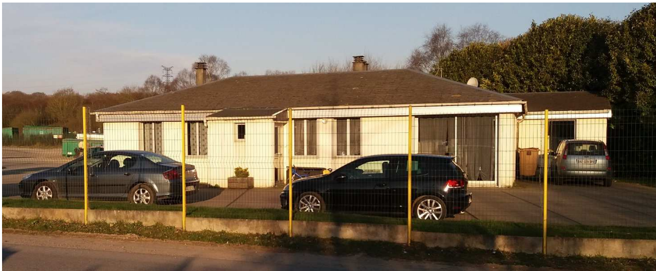
Figure 14 : Photographie du logement du gardien
