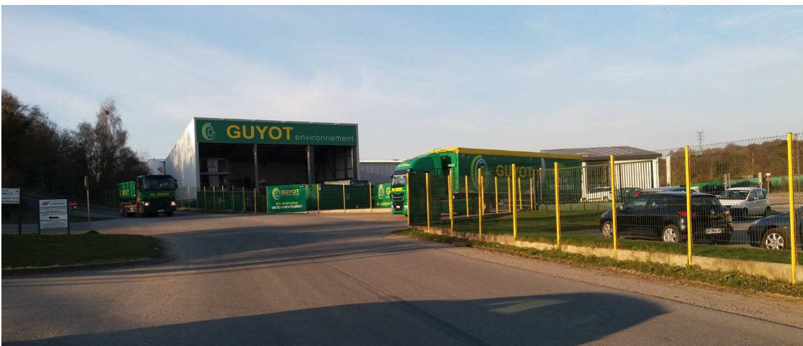
Figure 82 : Vue globale du site d'étude depuis la route de desserte
