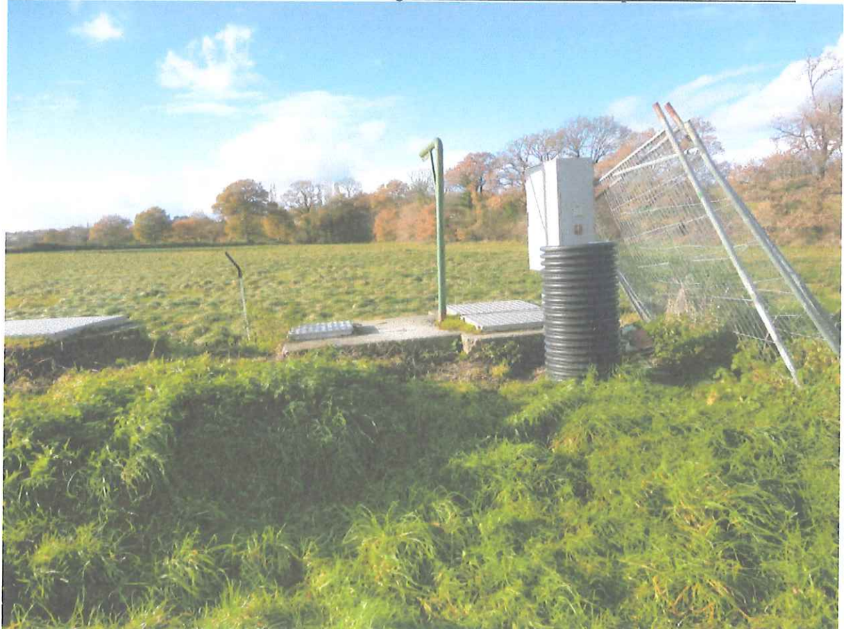
Poste de refoulement des eaux du bassin de gestion vers la station d'épuration de Carhaix
