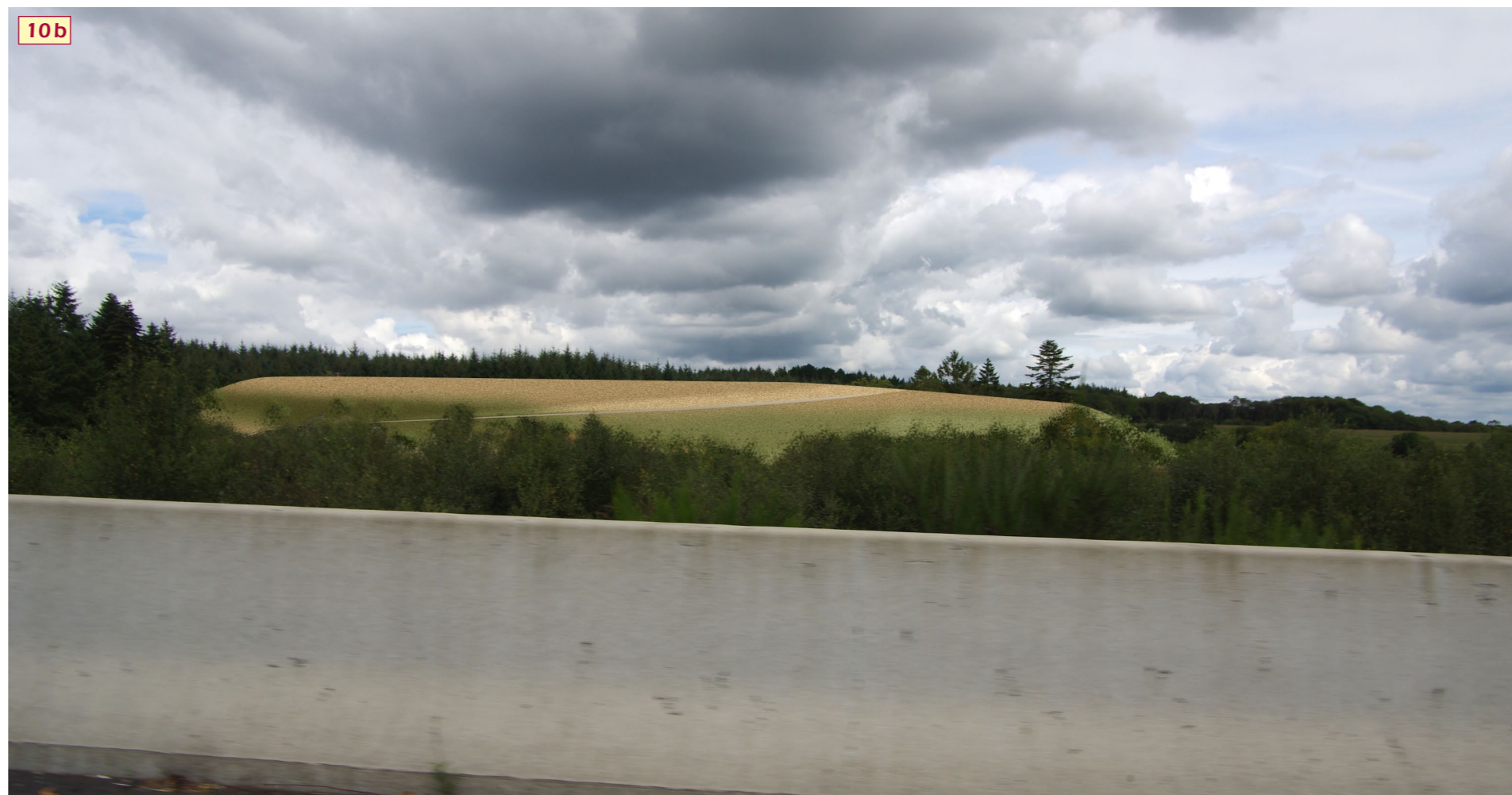
Silhouette finale du remblaiement, vu depuis la N 165 et représenté avant le développement de la végétation.
