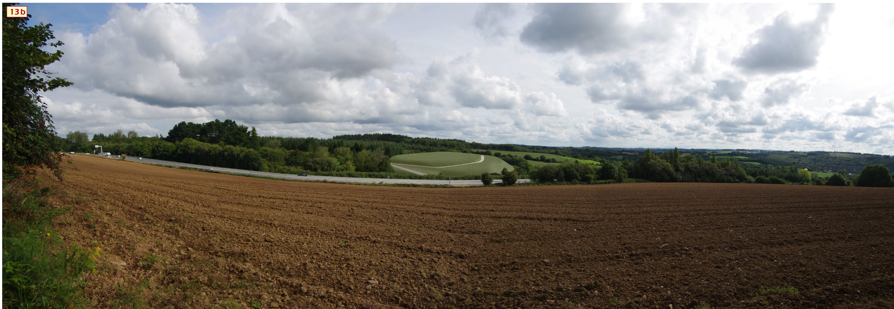
Silhouette finale du remblaiement, vue depuis la voie communale à l'ouest et représentée avant le développement de la végétation.
