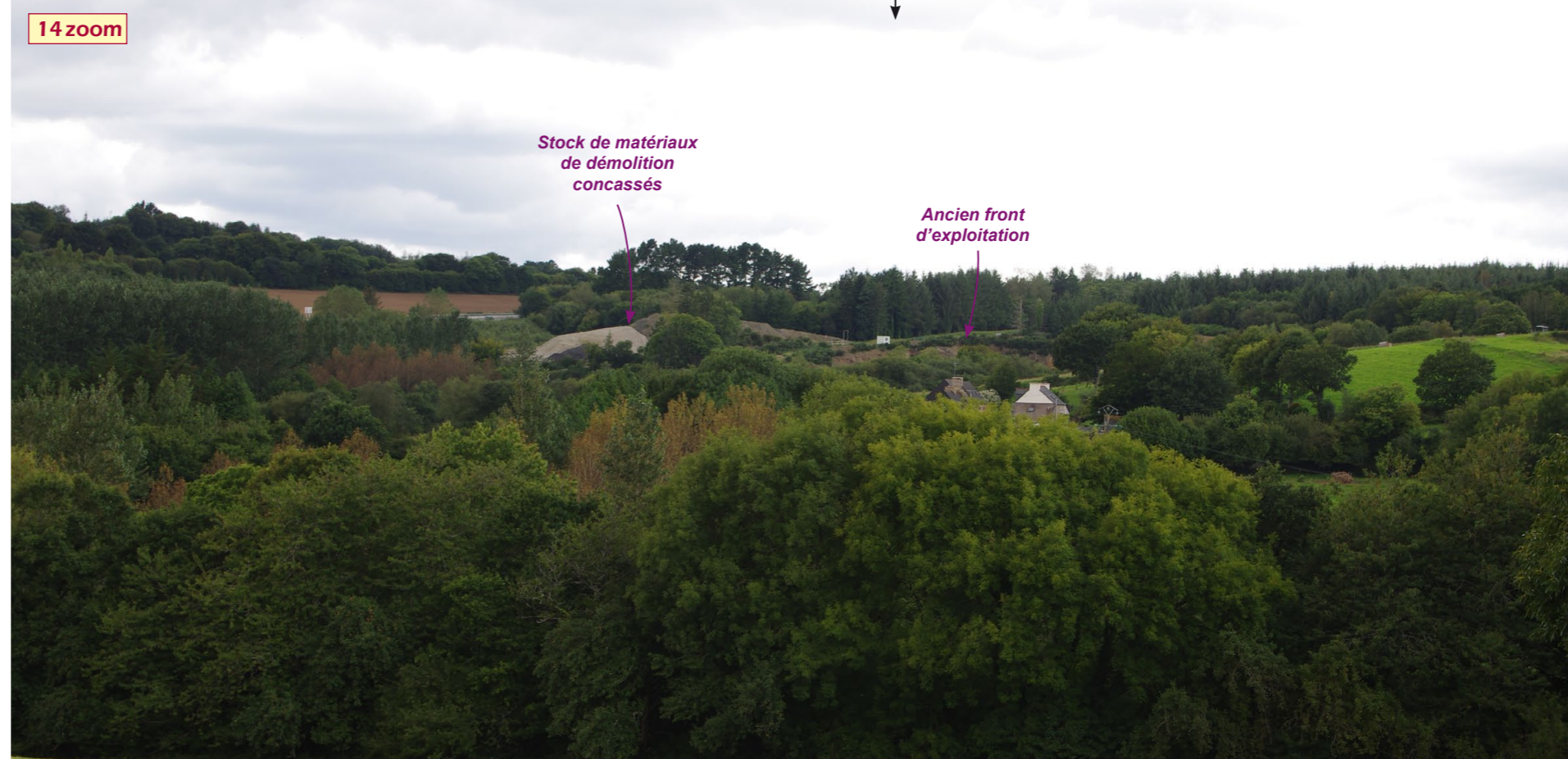
La carrière se signale par le stock des matériaux de démolition et, d'une manière moindre, par l'ancien front d'exploitation.
