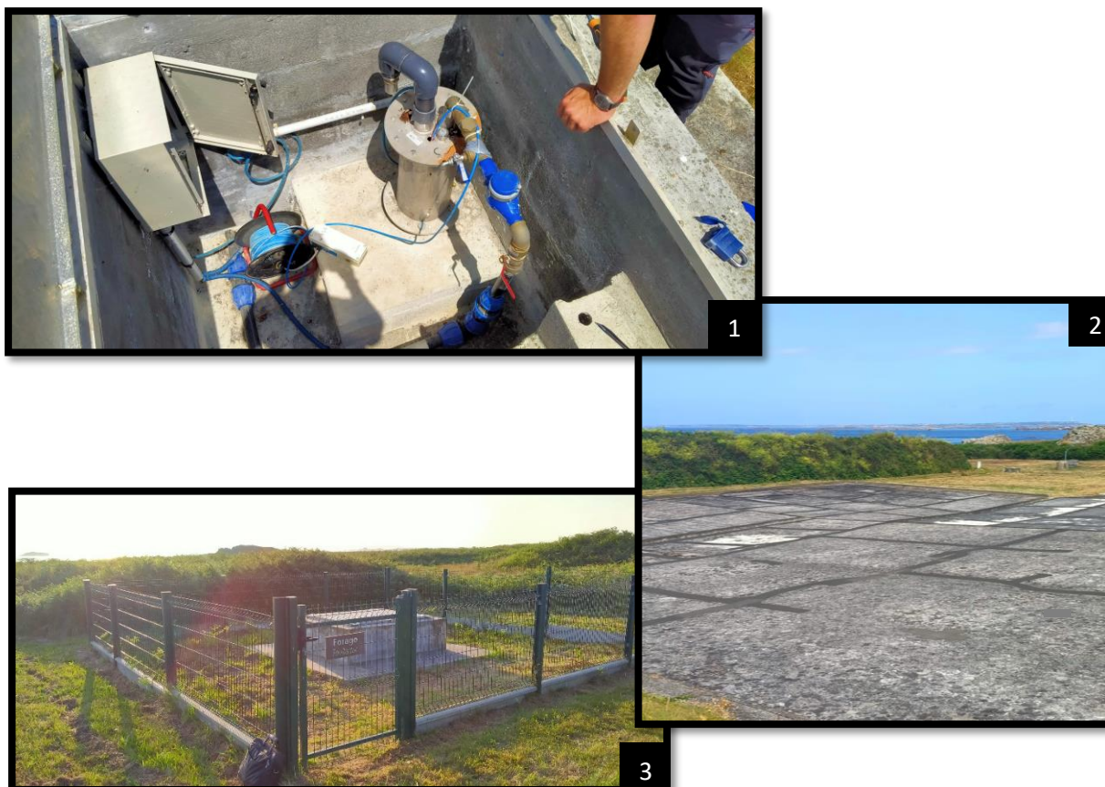
Figure 1 : photographies en cours d'études (1 : vue de l'intérieur du regard abritant F3 - 2 : impluvium de Molène - 3 : vue sur le regard du forage F2)
