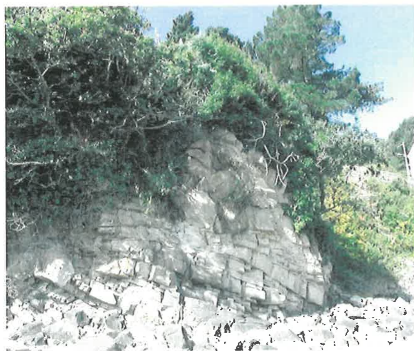
Affleurement de granite présentant un réseau de diaclases très serré (Ouest de la plage des Sables Blancs)
