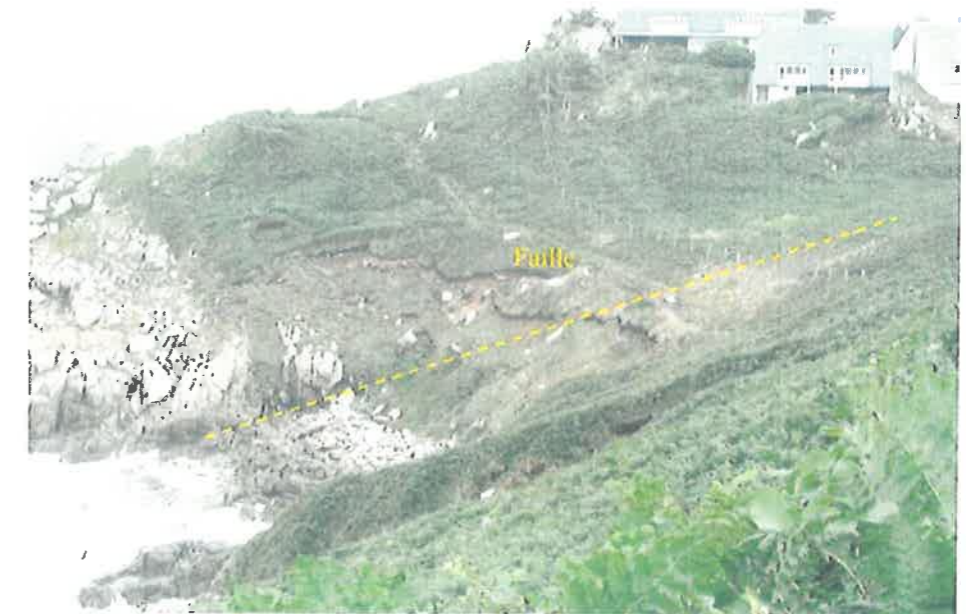
Exemple de glissement aux Roches Blanches
