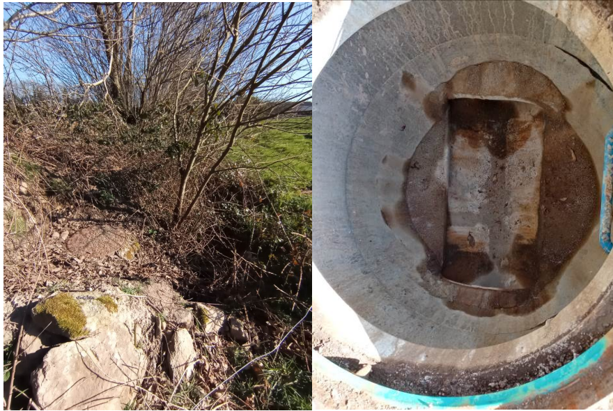
Figure 18 : Vues sur le réseau EP en Ø500 béton
