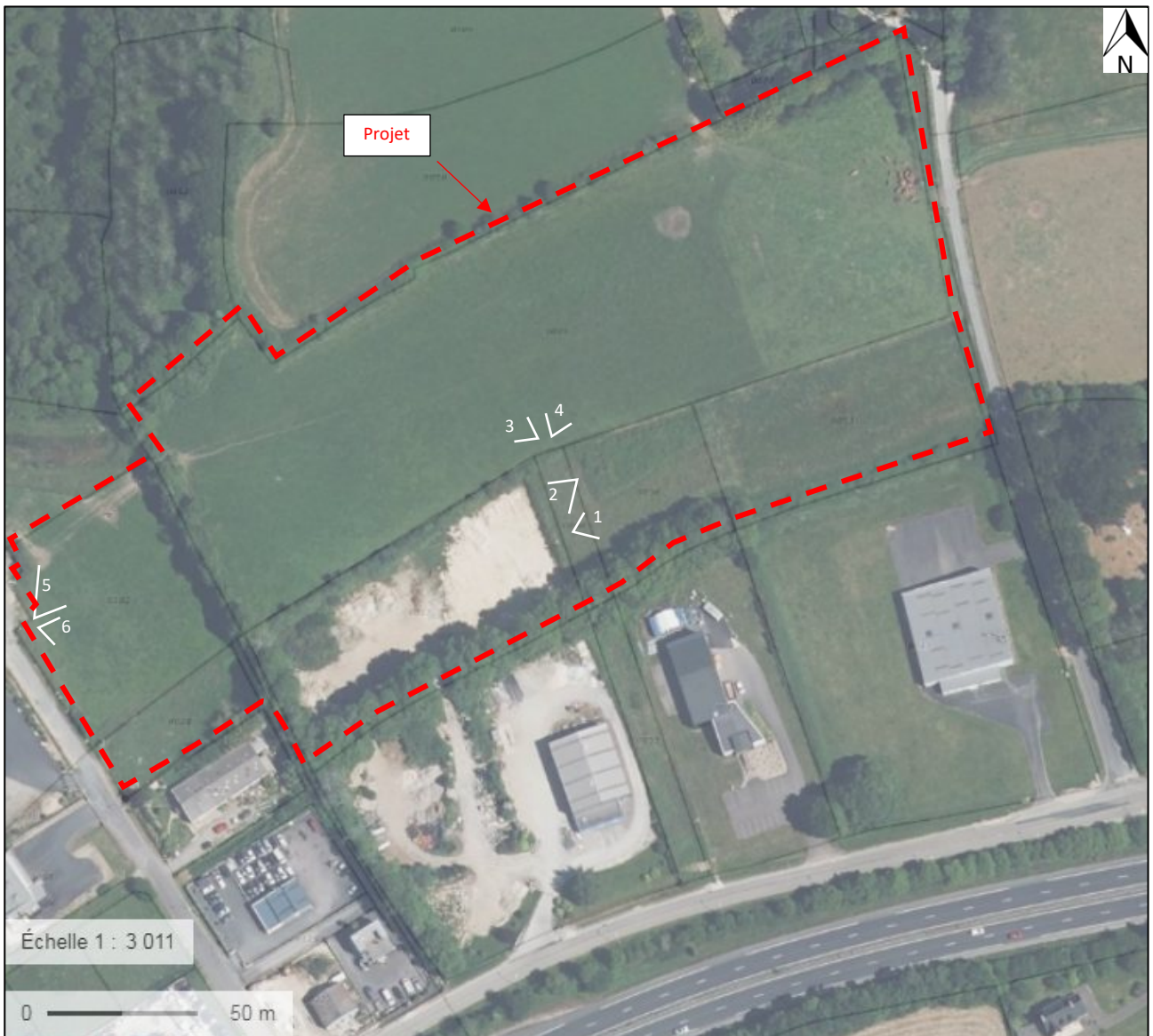
Figure 2 : Photographie aérienne de la zone de projet (Géoportail IGN 2018)
