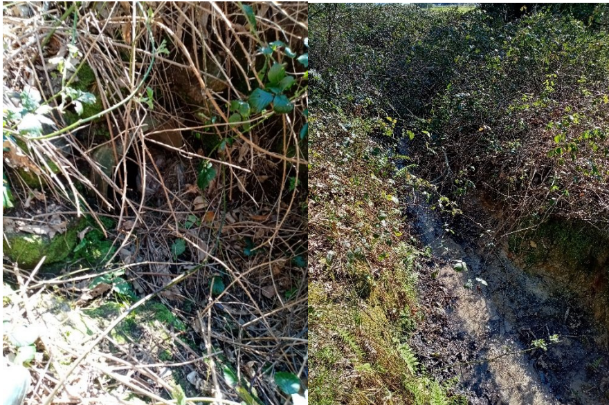
Figure 19 : Vues sur l'exutoire du réseau EP en Ø500 béton et le ruisseau de Keraval
