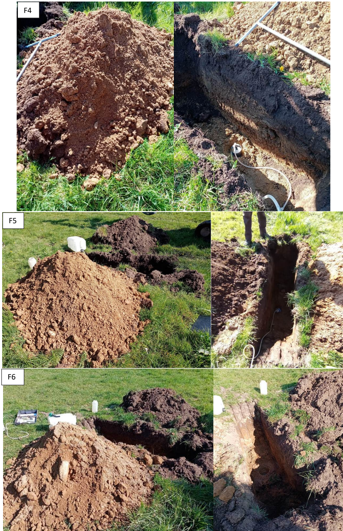
Figure 12 : Sondage à la tarière et test de perméabilité
