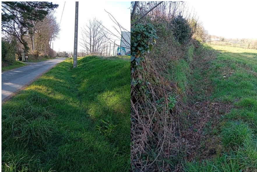
Figure 17 : Vues sur le fossé situé Chemin Hent-Kerroparz et la noue d'infiltration
