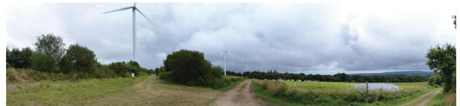
Vue panoramique depuis le cœur de la ZIP à la hauteur de la troisième éolienne, au milieu de l'alignement (Source : Atelier des Paysages)
