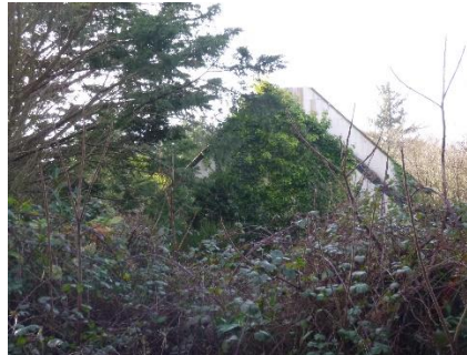
Photographie 2 : Maison en ruine
