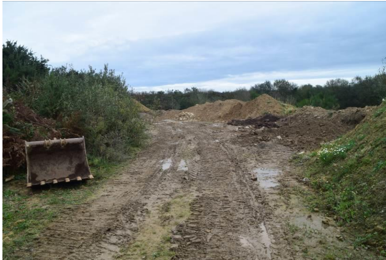
Zone décapée localisée dans l'emprise du site
