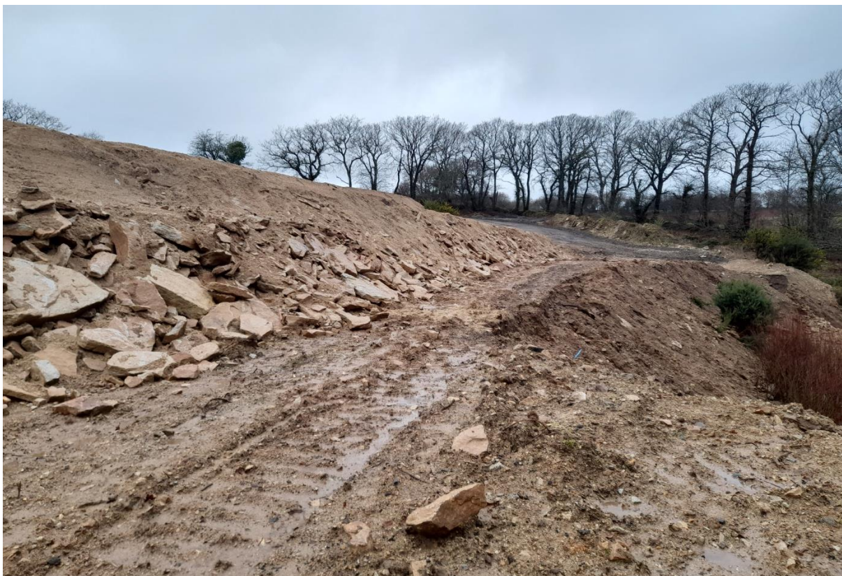
Photographie 16 : ISDI en cours d'exploitation – vue vers l'Est
