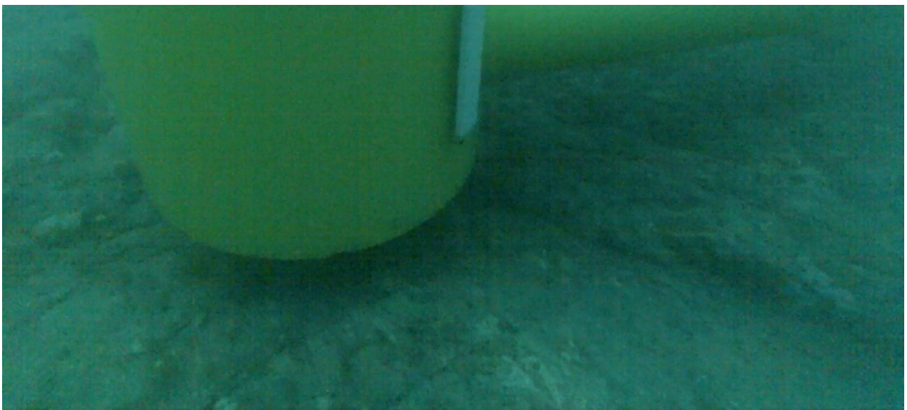
Figure 45 : Plongée du 23 août 2015, sur le tripode avant. Le fond semble être un pavement rocheux (source Sabella)
