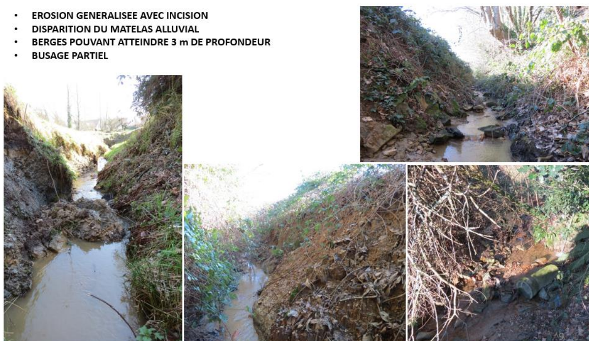
Figure 32 : Désordres hydrogéomorphologiques - segment 3 (Ouest-Am')
