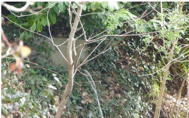
Figure 23 : Buse Ø300 du BV Nord alimentant le ruisseau (Ouest-Am')
