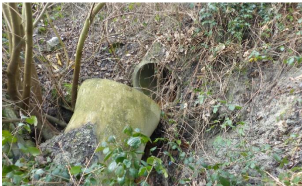
Figure 22 : Exutoire de la buse Ø800 (Ouest-Am')
