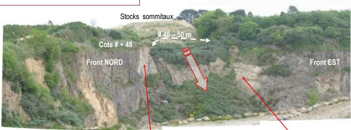
Glissement survenu en 2009 affectant les fronts 3 à 5 à l'angle Nord-Est sur environ 40 à 50 m de largeur et sur 5 à 15 m d'épaisseur en tête
