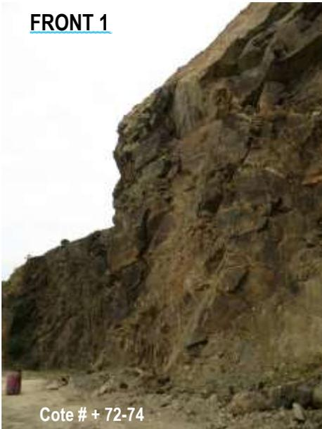
Front rocheux, altéré, très déstructuré (débit en blocs dm<sup>3</sup> à pluri-dm<sup>3</sup>)
