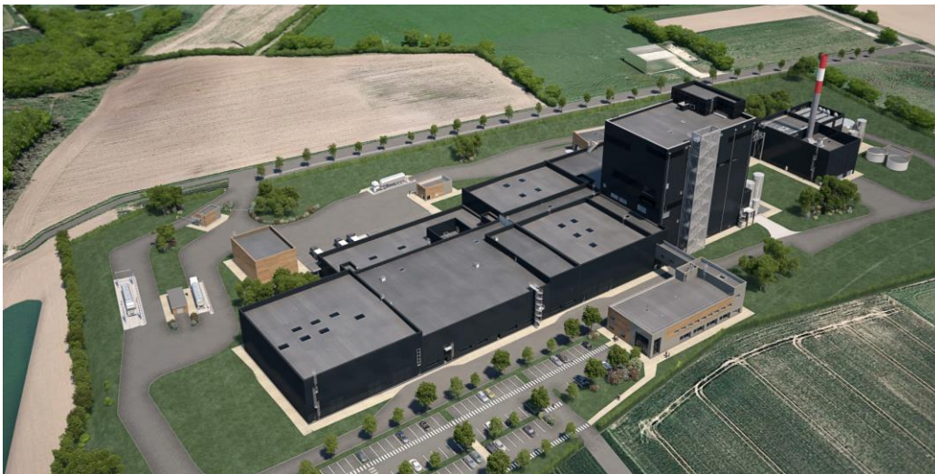
Insertion paysagère : vue aérienne depuis le Sud
